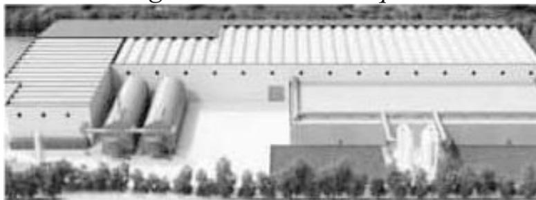
bagnato. Nel nostro impianto - aggiungeva Palma - non c'è combustione e quindi non c'è emissione di gas nell'aria circostante. Le 60 mila tonnellate annue di frazione umida vengono lavorate in due digestori a 55 gradi di temperatura.
